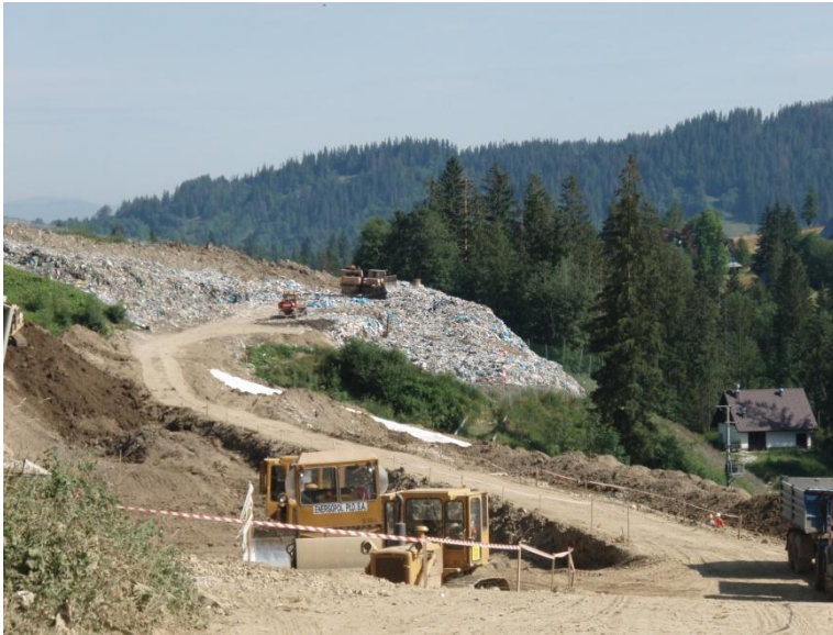
Rysunek 5 Zakopane "Wykorzystanie metanu pochodzącego ze składowiska odpadów i osadów ściekowych"
